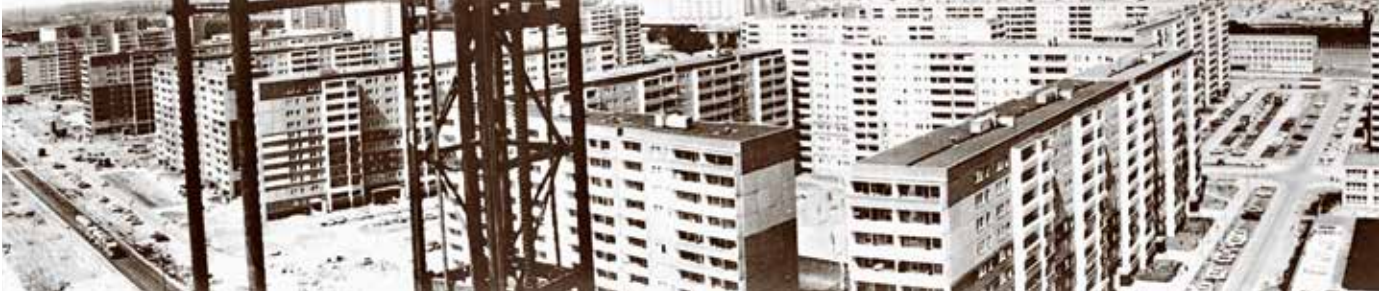
Rundblick über das Neubaugebiet Hohenschönhausen
