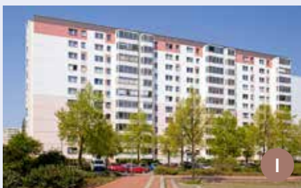
3. Wohngebiet Wustrower Straße 1, 3, 5 (Wohneigentumsanlage) 13051 Berlin Baujahr: 1984 Bestand: 127 WE, davon 90 WE im Bestand der WBG
