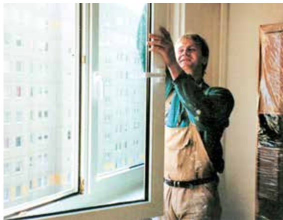
Einbau von Kunststofffenstern
