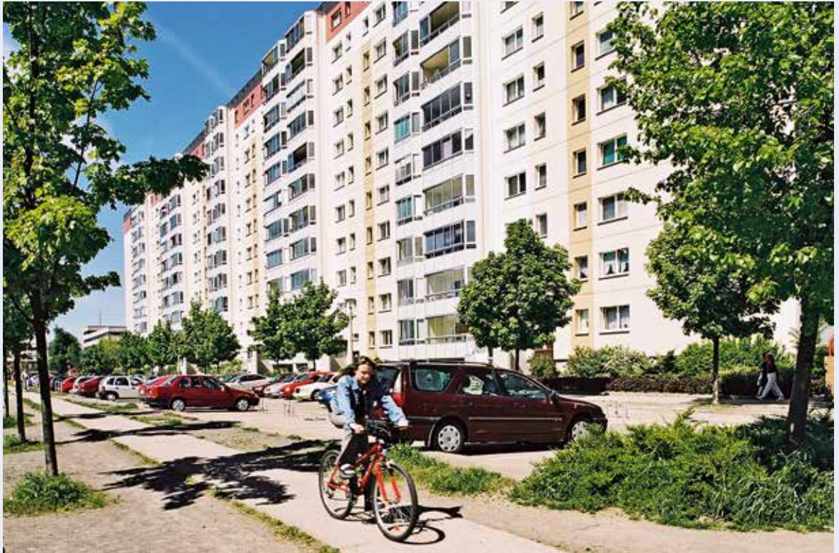
Die Pablo-Picasso- Straße 1 – 11 nach erfolgter Sanierung
