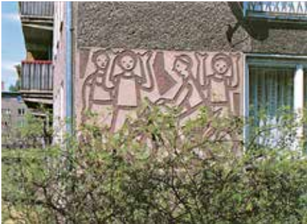
Relief an einer Giebelseite in der Oderbruchstraße, 1994
