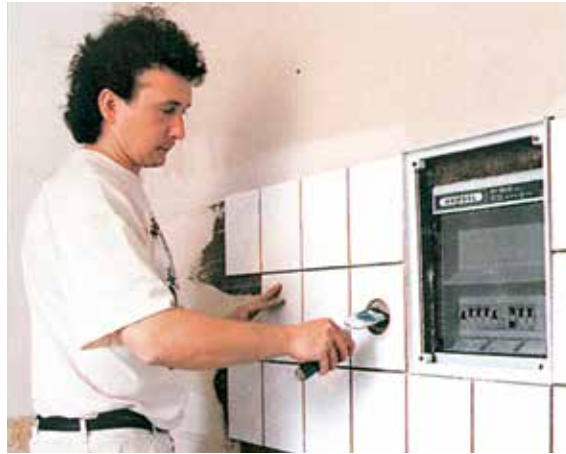
Abschluss der Arbeiten im Zuge der Strangsanierung
