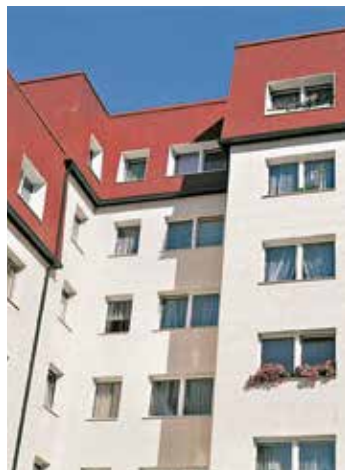
Karree Biesebrower Straße / Seehausener Straße / Pablo Picasso-Straße, August 1996
