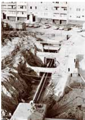
Bau der Versorgungsleitungen an der Rückseite der Wustrower Straße
