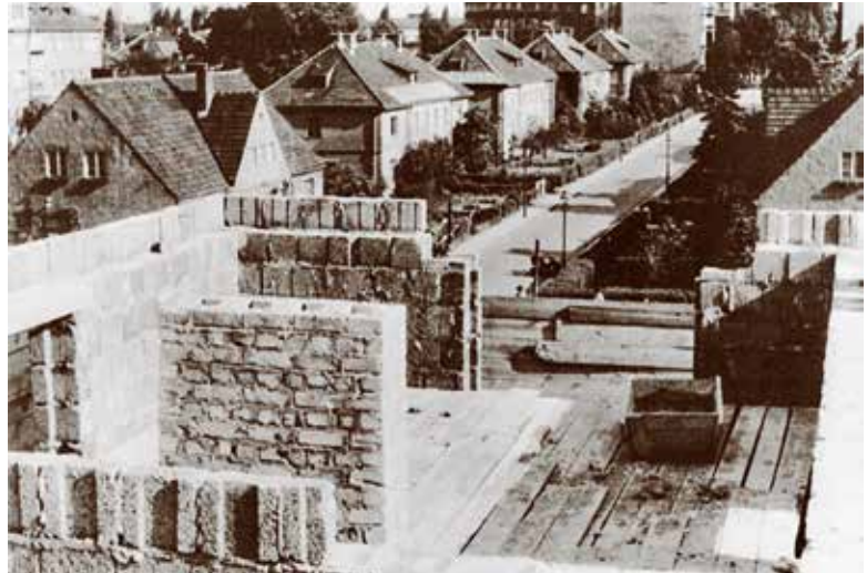
Baustelle Klaustaler Straße in Berlin-Pankow
