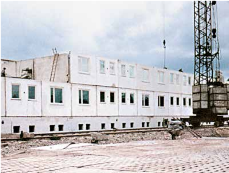
Baustelle des ersten Hauses in der Oderbruchstraße, Typ Q3A
