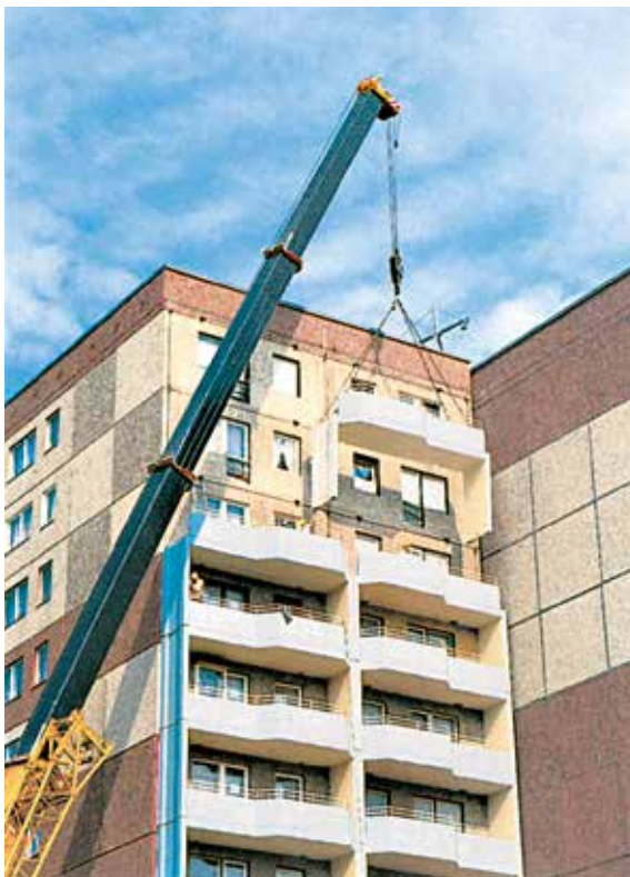
Balkonerneuerung in der Ahrens- hooper Straße 61
