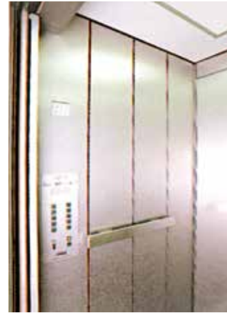
Aufzüge in den Elftgeschossern werden modernisiert
